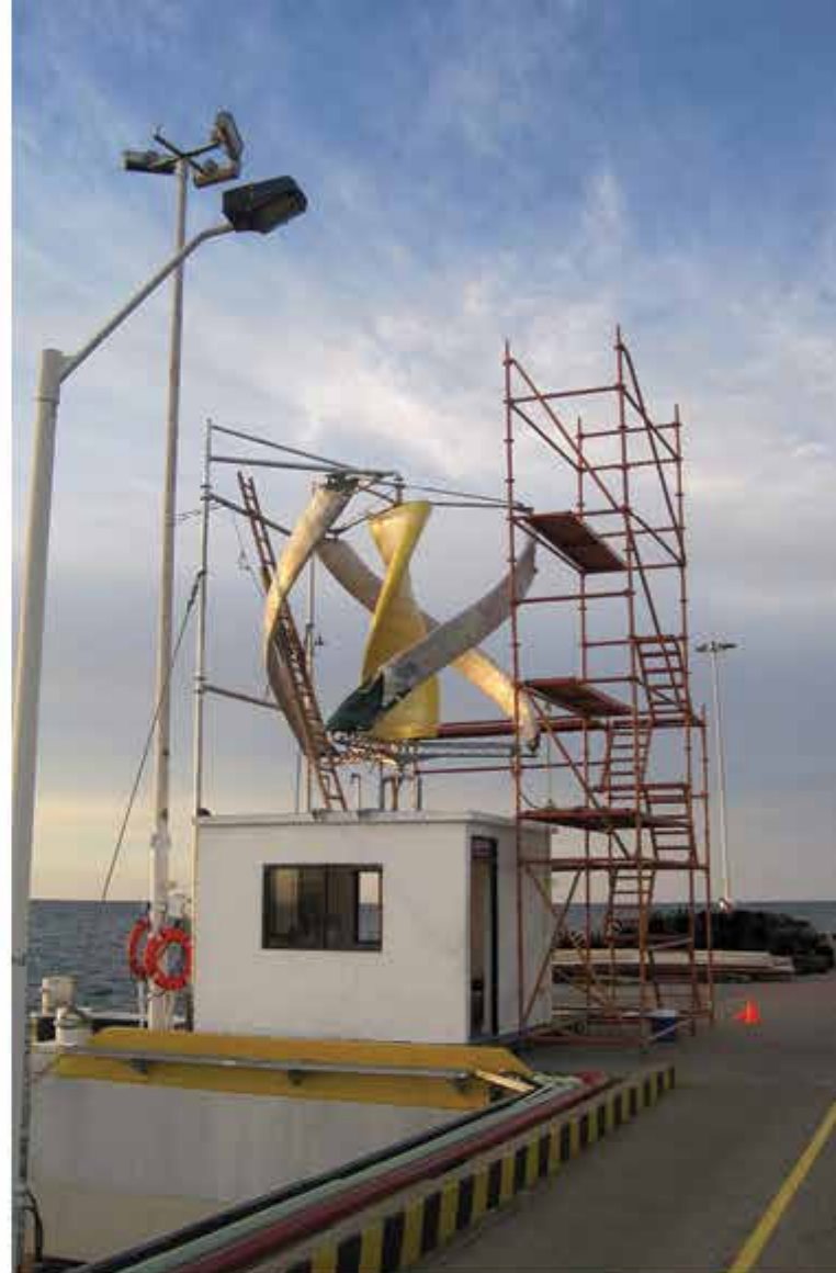
Proceso de montaje: todos los perfiles instalados, pero aun protegidos por el material de transporte.
