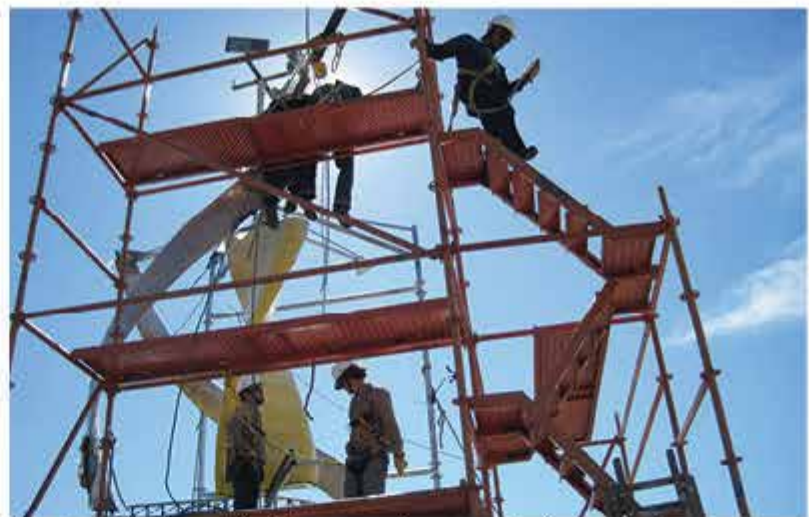
Procedimiento de montaje del aerogenerador con andamios certificados
