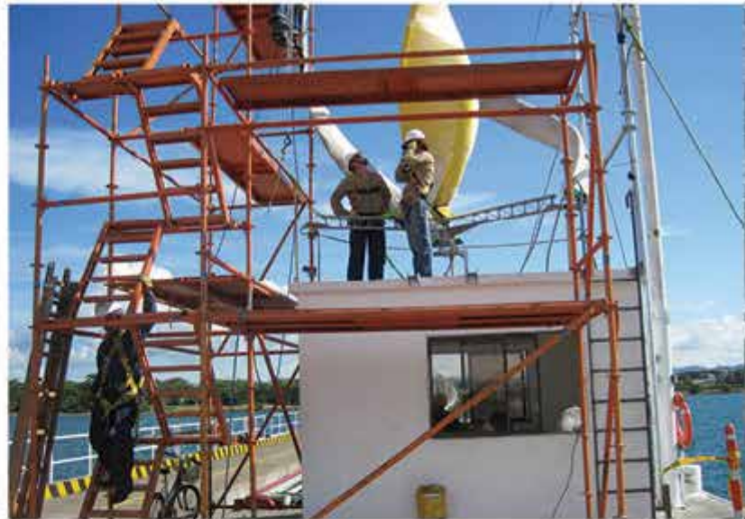
Dos de tres perfiles externos instalados... se planea la instalación del tercero y último de los perfiles externos.
