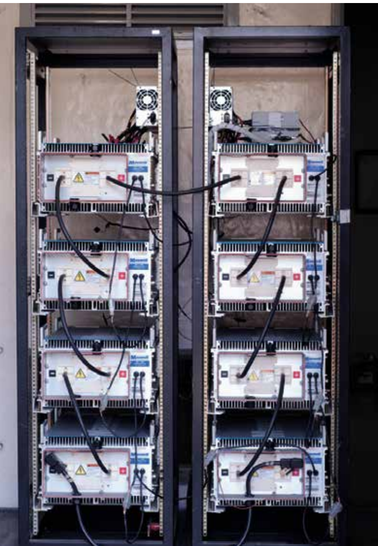
La tecnología desarrollada permite la reutilización de energía en el Sistema Metro.
